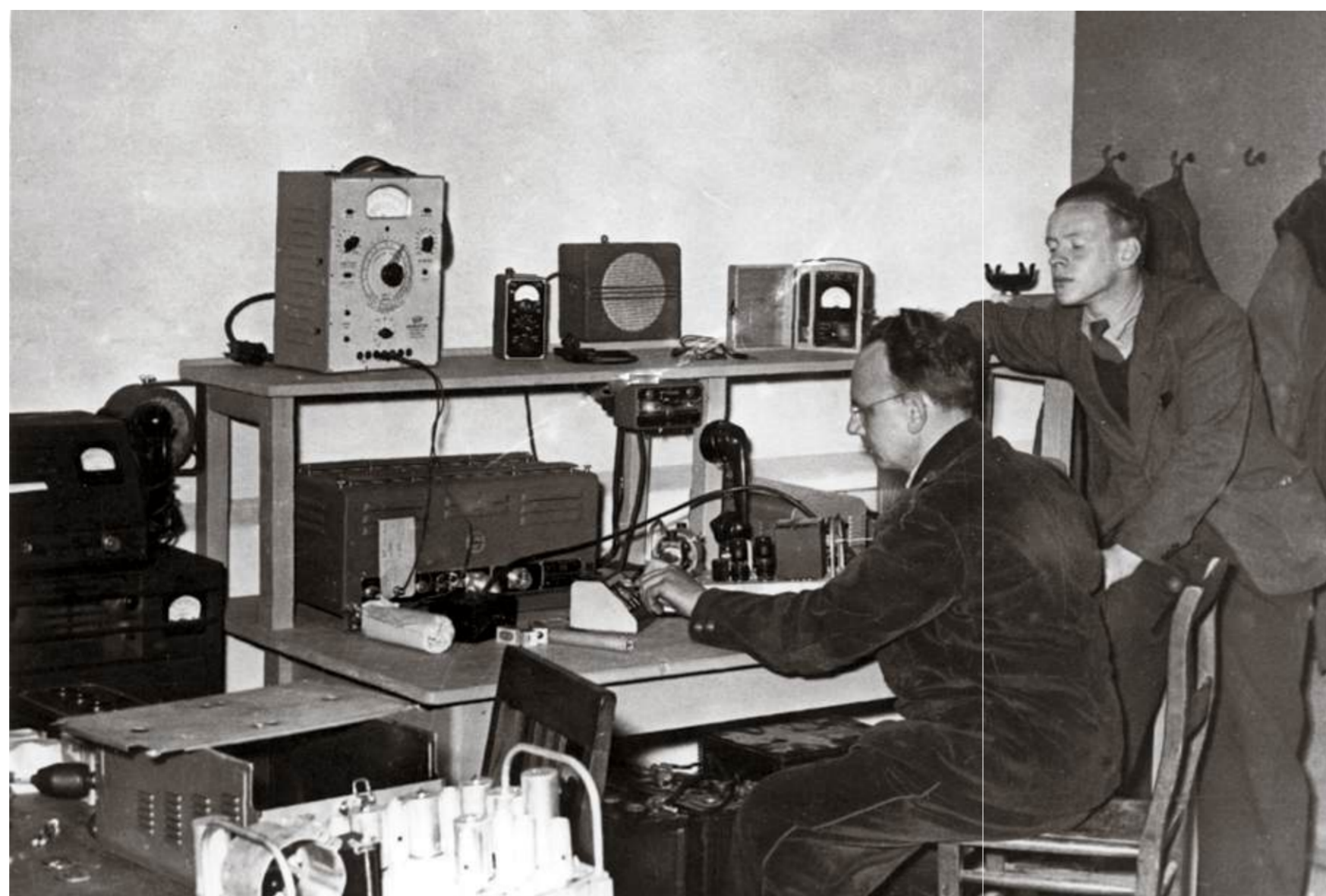
Na de Watersnoodramp in 1953 was overduidelijk dat Zierikzee een goede moderne draadloze verbinding nodig had. Op de foto uit dat jaar apparatuur van de draadomroep en mobilifoondienst in het PT-kantoor. Rechts zendamateur Van de Bosch. De apparatuur op plank v.l.n.r.: meetzender, hoogfrequentveldsterktemeter, luidspreker en testkastje; links op de tafel 'Link' zender/ontvanger Pye. Collectie Jan Bruijns. ZB/Beeldbank Zeeland, rec.nr. 48888
